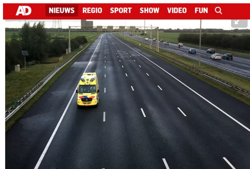
▲ Het nieuwe asfalt op de A12. © Rianne den Balvert
