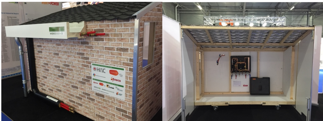
Figuur 1. Mock-up van de Warmtegoot, een van de zes productideeën volgens het concept principe 'Warmte door de Lucht'. Links de integratie van aanvoer en retourleiding in de dakgoot en rechts de warmteafgifteset op zolder.
