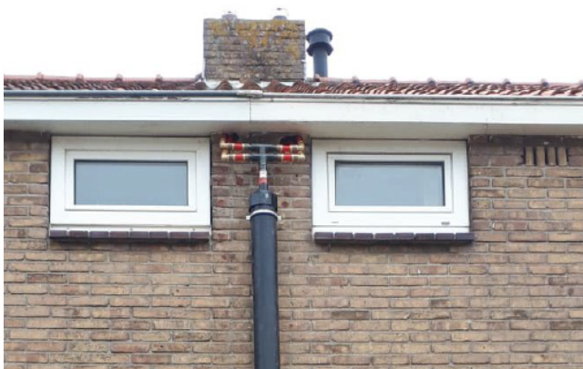
Bij het 'Calpex project' voor Stadsverwarming Purmerend zijn de eerste testen gedaan voor de verticale invoer.
