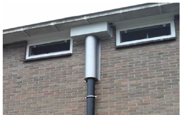
Door middel van een isolerende beschermingskap wordt het koppelpunt afgedekt.
