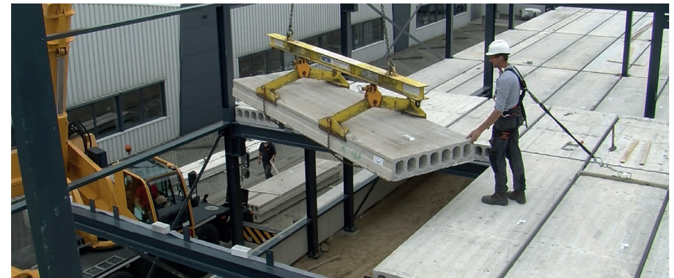
Figuur 49. Montage kanaalplaatvloer
